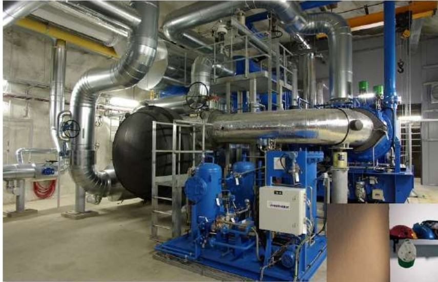
Wärmepumpe 20.000 kW
